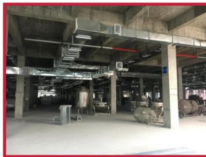
3)前处理车间一层净化区彩钢板立板已全部完成,顶板施工;各楼层工艺管道、通风管道、消防管道、电缆桥架制作及安装;大型设备已就位安装;
