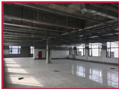
2)提取车间一层彩钢板立板已全部完成,顶板施工;各楼层工艺管道、通风管道、消防管道、电缆桥架制作及安装;大型设备已陆续就位安装;
